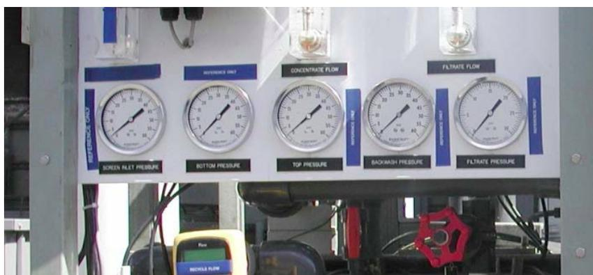
图 1a 同一高度的压力表示例
